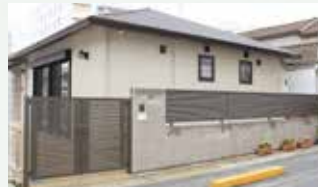
増築された園舎
